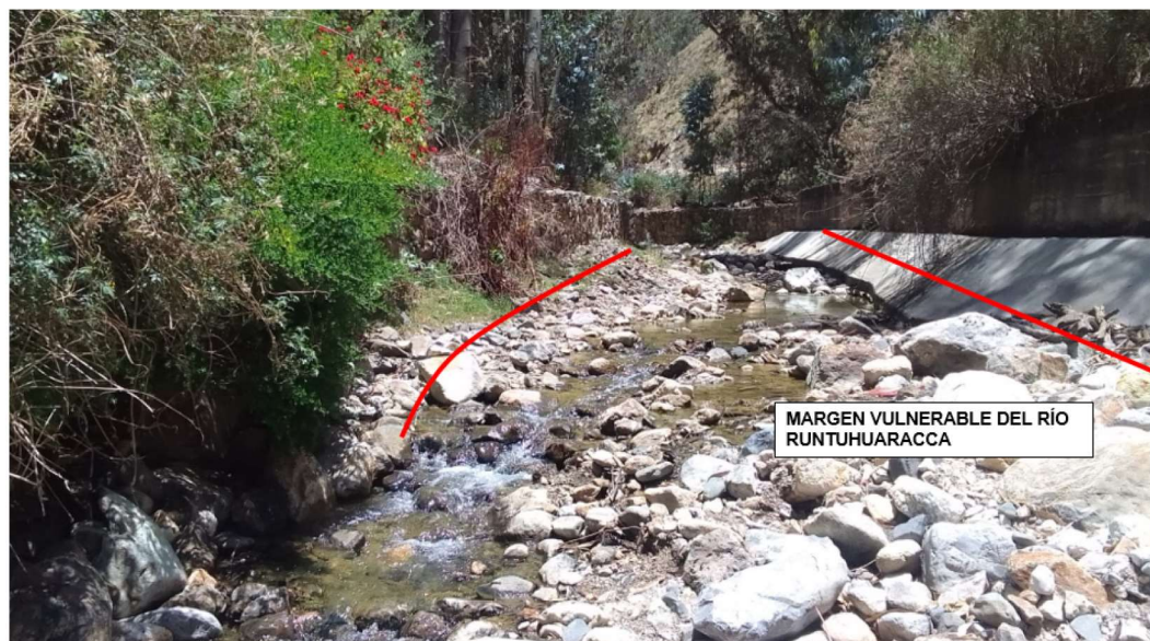
FIGURA N°02: ZONA VULNERABLE MARGEN IZQUIERDO VIVIENDAS; MARGEN DERECHO VIVIENDAS PRESENCIA DE MUROS DETERIORADOS A CAUSA DEL INCREMENTO DEL CAUDAL DISTRITO DE PALCA REGION
